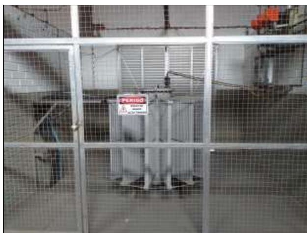
Foto 25 – Transformador Elétrico de 1000KVA
