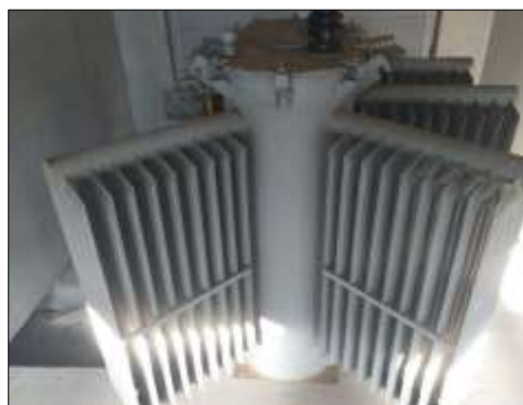
Foto 24 – Transformador Elétrico 1000 KVA
